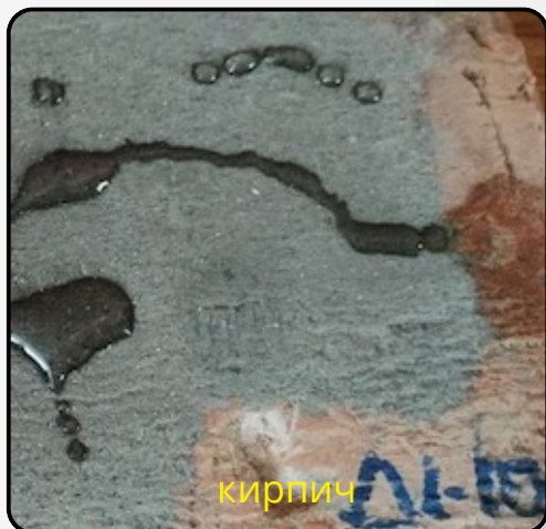
Поверхность уже через сутки после нанесения отлично держит воду
